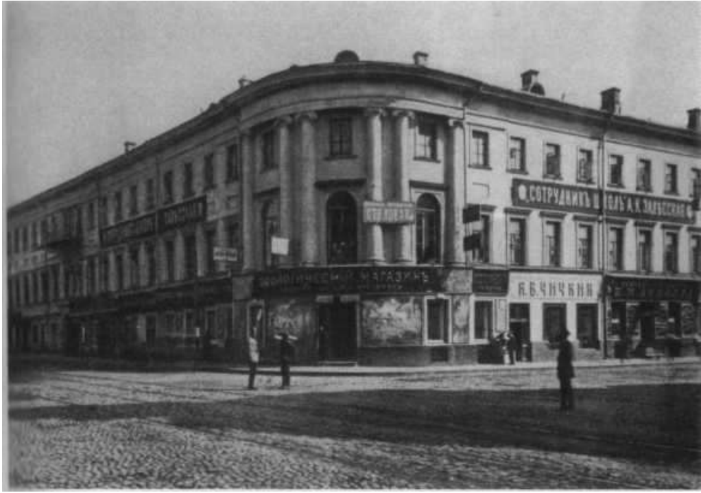
Gebäude des Moskauer Konservatoriums in der Wosdwischenka-Straße (nicht erhalten). Zweite Hälfte des XIX. Jh.
