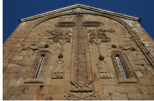
Ananuri, Fassade der Kirche Mariä Himmelfahrt
