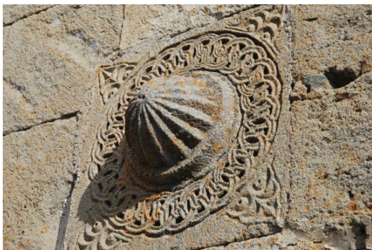
Гегретская церковь, орнамент фасада
